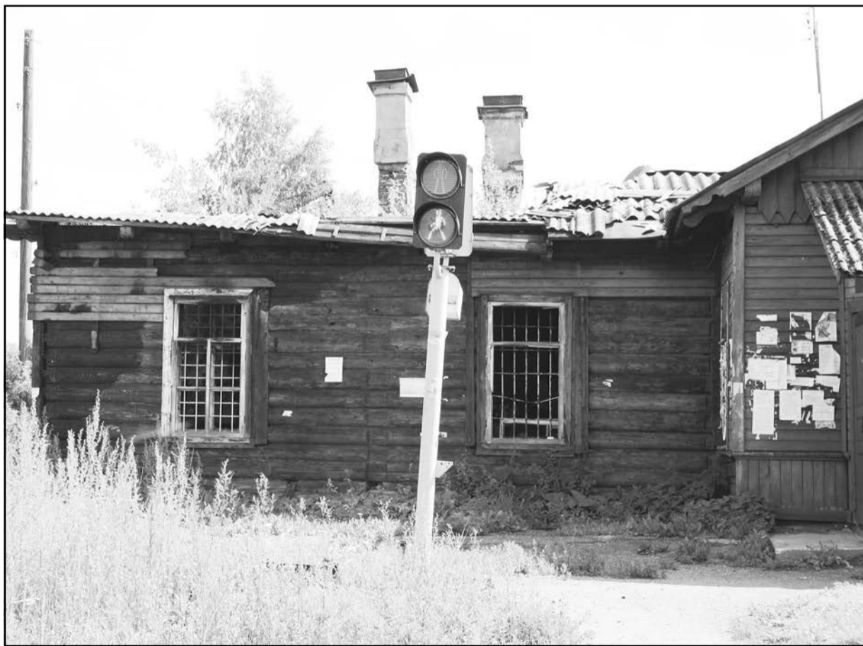
Здание, в котором расположены кассы и зал ожидания, 2015 год.
